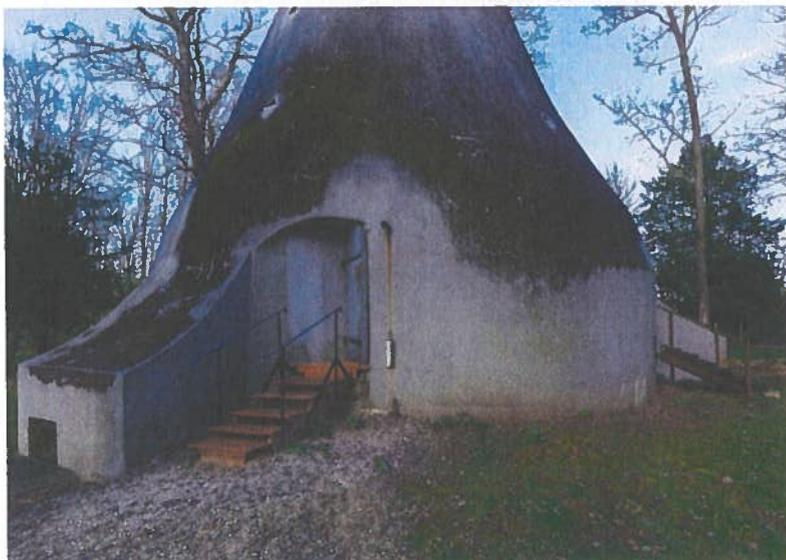
En cas de bombardement on place intérieurement dans chaque ouverture triangulaire un lourd bouclier en fer (5,5 kg) afin de parer à l'éventuelle intrusion d'un éclat ; un volet métallique également triangulaire pivote et vient compléter la fermeture. Celle-ci n'est pas étanche aux gaz comme dans d'autres abris disposants de joints d'étanchéité ; seule une légère surpression intérieure générée par la ventilation (le « vélo ») peut y remédier. (voir photos page précédente)
