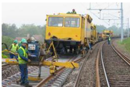
*Figure 37: Longs rails soudés sur traverses béton*
