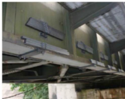
Figure 40: Absorbeur sur platelage
