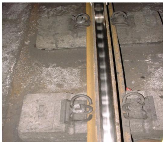
Figure 49: Usure ondulatoire sur une section de rail
