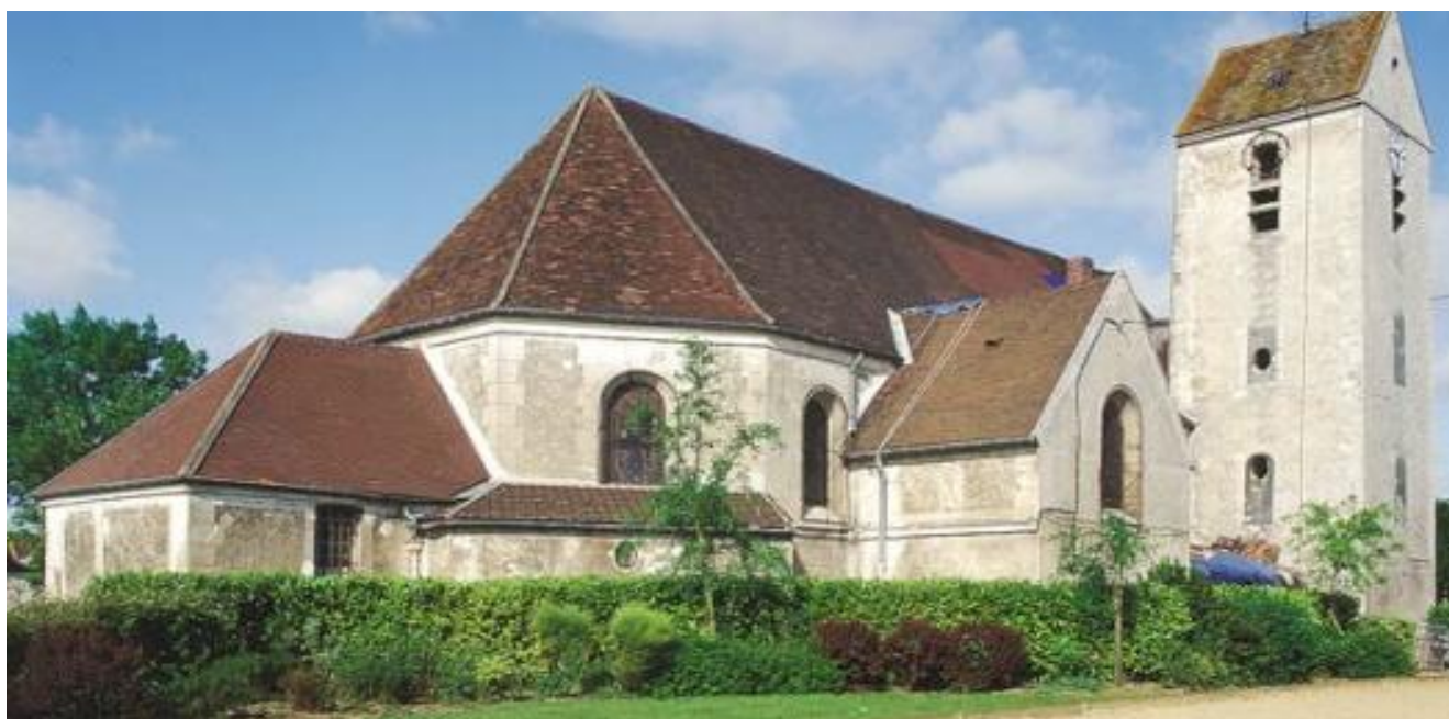
Source : Eglise Sainte-Aldegonde- Patrimoine religieux de Seine-et-Marne
