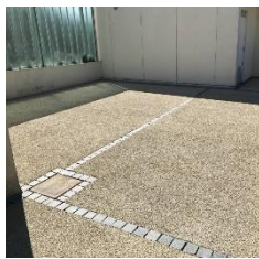
Béton drainant et poreux
