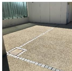
Béton drainant et poreux
