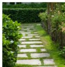
Pavés à joints enherbés
