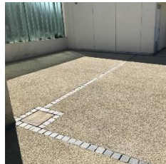
Béton drainant et poreux
