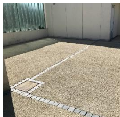
Béton drainant et poreux
