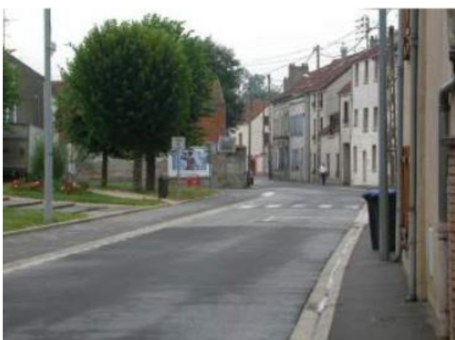
Source : Bâti du centre ancien, rue Thiers- Commune de Villenoy
