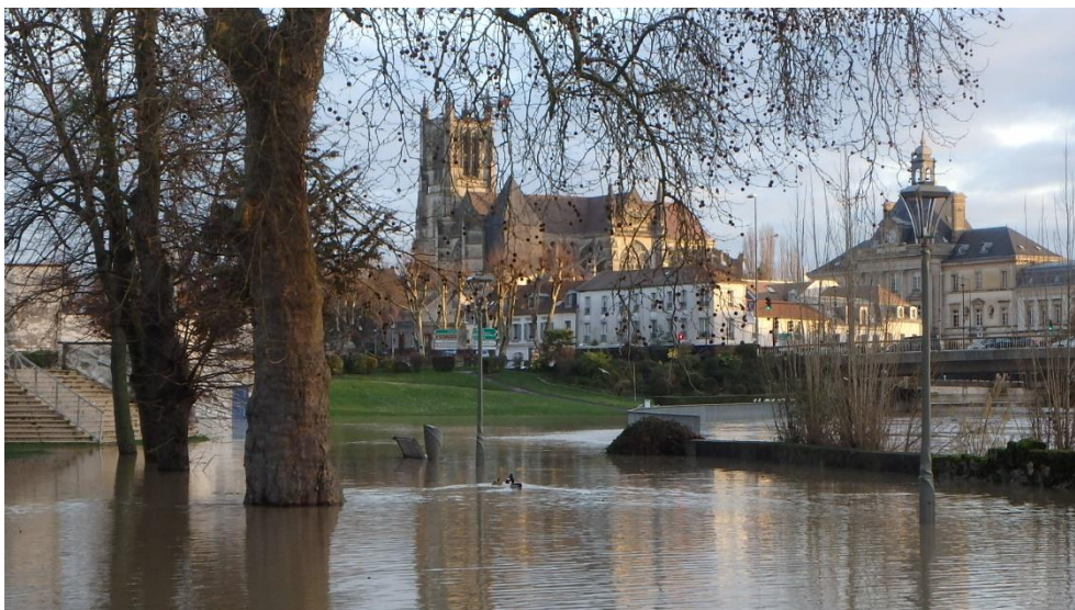
Inondation par débordement de la Marne, Meaux, Janvier 2018.
