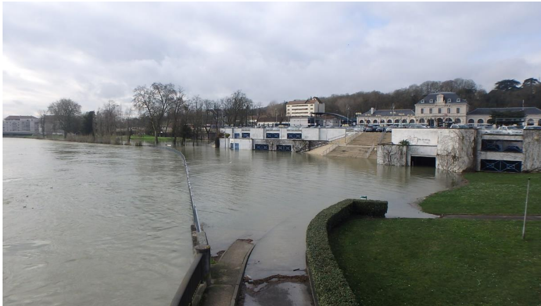
Inondation des accès du parking de la gare pendant les inondations de janvier 2018
